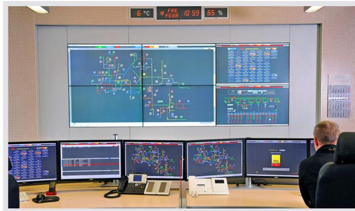
**JST Großbildwand:** Mit der Großbildtechnik aus dem Hause JST werden im technischen Leitstand des KCO die Stromlaufpläne der Berliner Verkehrsbetriebe dargestellt. Über die von JST genutzten LC-Displays haben die Mitarbeiter die Möglichkeit, ein Bild sehr groß und rahmenübergreifend als Big-Picture über mehrere Displays darzustellen – ultraschmale Rahmen und MultiConsoling® machen es möglich.
