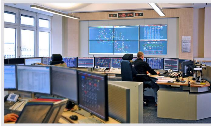
**JST-MultiConsoling®**: Herzstück der Technik ist das MultiConsoling®, mit dem alle Rechner aus der Leitstelle in einem entfernten Technikraum installiert werden konnten. Vorteil: weniger Wärme, weniger Geräusche. Zudem werden die Rechner – je nach Zugriffsberechtigung – von den Operatoren beliebig auf die Großbildwand und die Monitore am Arbeitsplatz verschaltet und in Realtime bedient.
