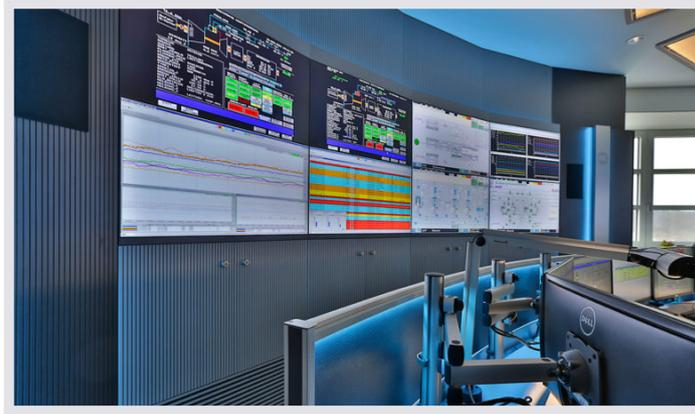
JST Großbildtechnik: Eine von insgesamt vier Großbildwänden in der Zentralwarte; hier bestehend aus acht 46 Zoll großen Displays mit extra-schmalen Rahmen, die sich perfekt auch für die Darstellung von BigPictures (Vollbilddarstellung über mehrere Displays) eignet. Im Vordergrund zu sehen: Die höhenverstellbaren 3D-Gelenkarme ermöglichen eine parabolische Anordnung der Arbeitsplatz-Monitore und bieten dem Anwender so ein optimales Sichtfeld.
