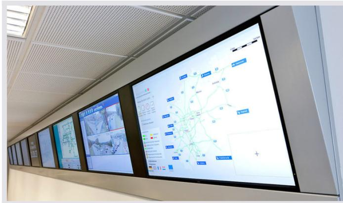
**Optimale Raumplanung** – die Großbilddisplays sind so hoch angebracht, dass der/die Operator/-in über die zweite Bildschirmebene am Arbeitsplatz hinweg das Geschehen auf der Großbildwand verfolgen kann.
