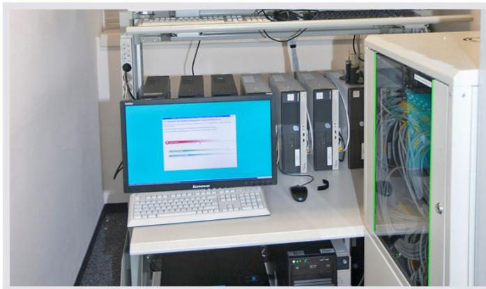
**JST-Technikraum:** Raum-in-Raum-Konzept hinter der Videowall – die gesamte Technik inklusive Workstations der Arbeitsplätze wurde mittels MultiConsoling® vom Arbeitsplatz entfernt hier installiert. Im Leitstand entstehen dadurch weniger Wärme und Geräusche.
