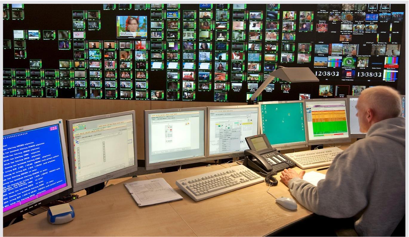
Die Integration einer Video-Rückprojektionswand mit über 250 TV-Bildern und die neue proaktive Anzeigewand mit großen variabel zusammenschalteten LC-Displays war eine weitere Herausforderung an JST.
