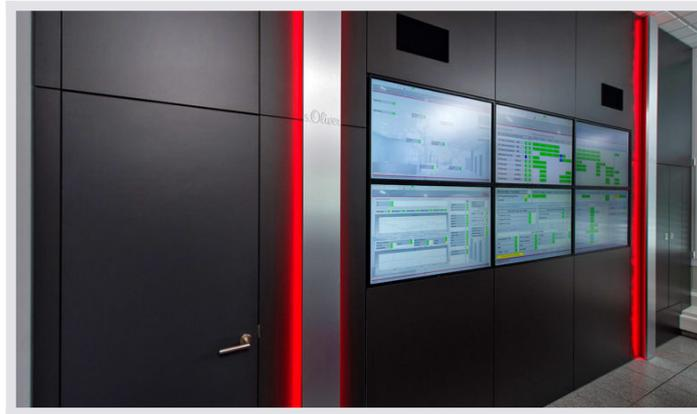
JST Großbildwand: Direkt neben den Displays der Großbildwand befindet sich eine Tür, die Zugang zum neugeschaffenen Raum-im-Raum bietet – eine spezielle JST-Lösung, die Wärme und Geräusche vom Leitstand fernhält.
