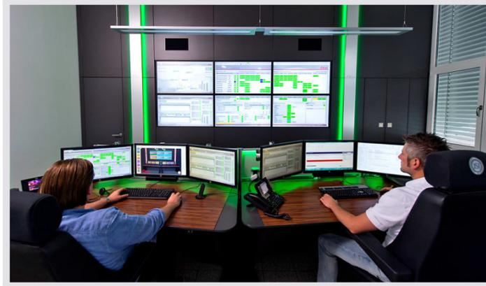
JST Kontrollraum: Blick in den s.Oliver Leitstand nach der Optimierung. Die Großbildwand wurde um zwei weitere Displays ergänzt. Zudem bietet die neue Bildwandverkleidung nicht nur optische Vorteile, Wärme und Geräusche werden im Kontrollraum jetzt deutlich reduziert.
