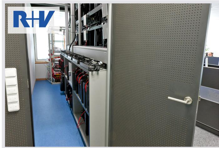
... Zugang zum Raum-in-Raum-Konzept hinter der Videowall bietet. Die gesamte Technik inklusive Workstations der Arbeitsplätze wurde mittels MultiConsoling® vom Arbeitsplatz entfernt hier installiert. Im Kontrollraum entstehen dadurch weniger Wärme und Geräusche.
