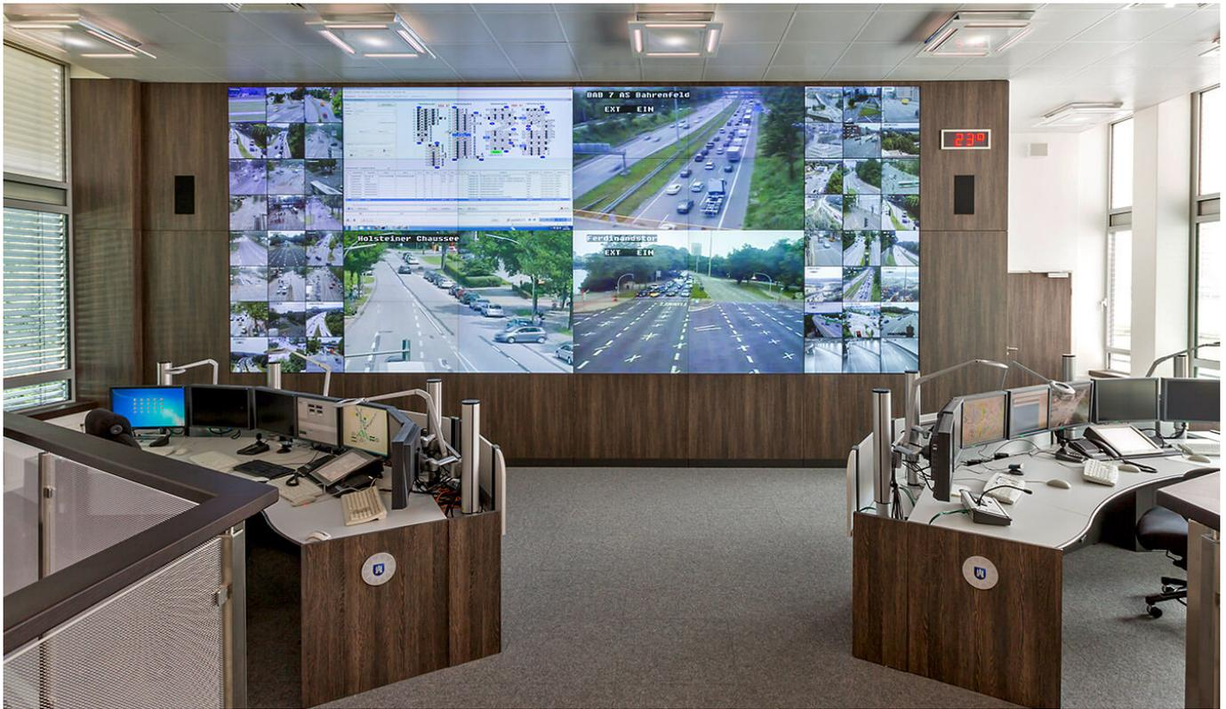
Innovative Cube-Großbildtechnik hat in der Verkehrsleitzentrale der Polizei Hamburg eine 20 Jahre alte Leuchtdiodenkarte abgelöst. Die dynamische Großbildwand macht es möglich, circa 120 Rechner- und Kamerasignale in Realtime aufzuschalten. Zusätzlich können diese Signale auf 50 Multikonsolen der Arbeitsplätze dargestellt und bedient werden. Per Mausklick kann bei Bedarf eine Kamera auf mehrere Cubes geschaltet werden – so lassen sich Gefahrensituationen differenziert beurteilen.
