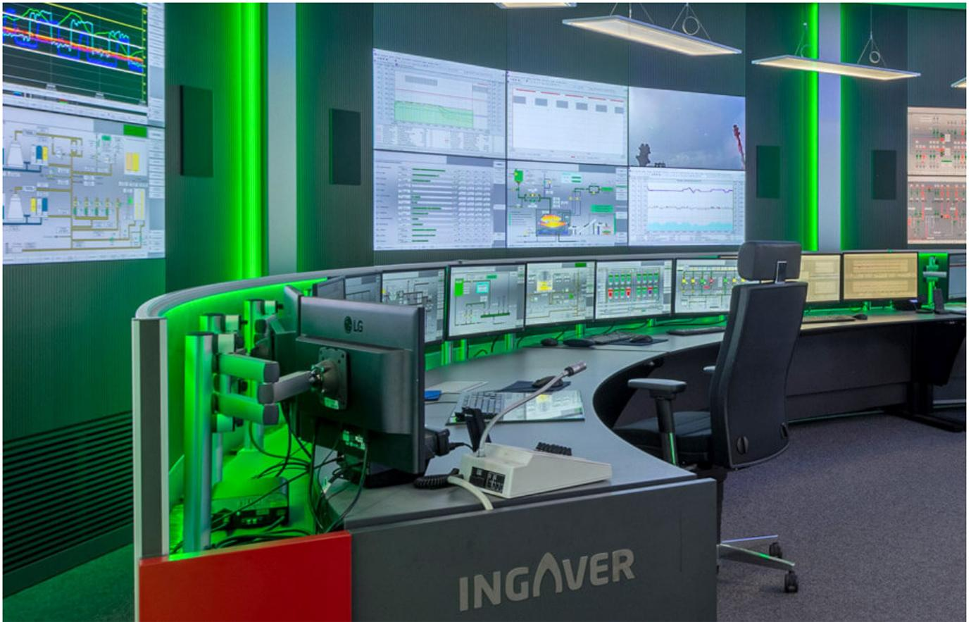
Das AlarmLight Lichtband befindet sich in den Edelstahlstreifen links und rechts neben der Großbildwand; optional auch integriert in die Rückwand des Stratos Operator Desks. Durch eventgesteuerte Lichtsignale über Ihr Monitoring- oder Prozessleitsystem wird der Fokus des Kontrollraumteams direkt auf kritische Alarmer gelenkt.
