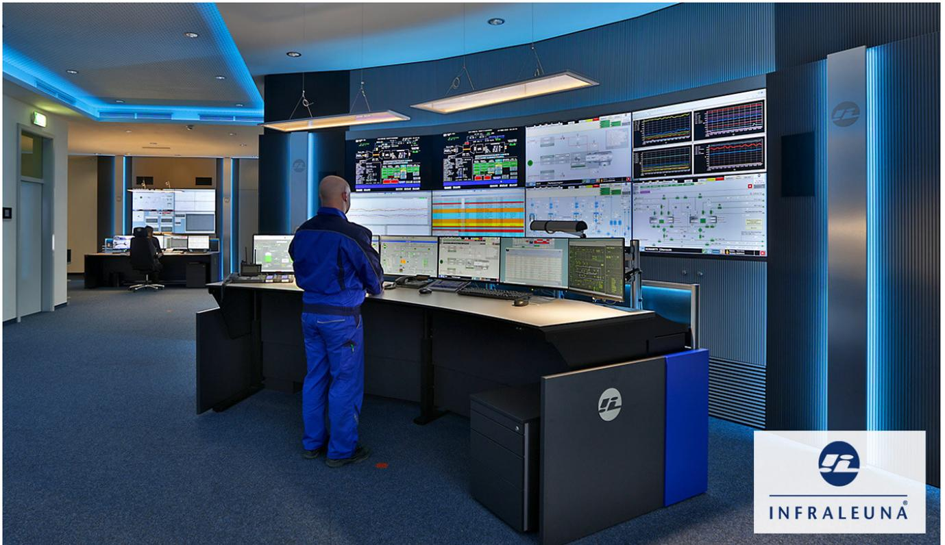
In der zentralen Leitwarte auf dem Betriebsgelände der InfraLeuna wurden insgesamt vier Großbildwände installiert. Die Displays mit extra-schmalen Rahmen eignen sich perfekt für die Darstellung von BigPictures (Vollbilddarstellung über mehrere Displays). Zur Schallminimierung wurden die DisplayCover der Großbildwand mit speziellen Paneelen in Akustikausführung versehen. Eine multifunktionale Ausstattung mit Flügeltüren bietet zusätzlichen Stauraum im unteren Bereich der Wall.
