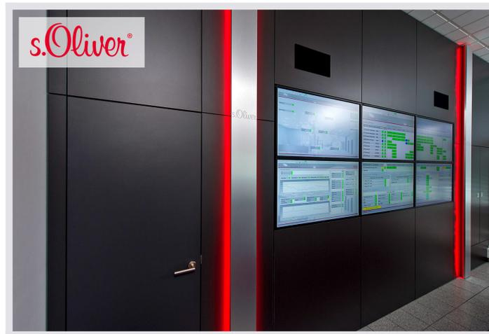
**JST Großbildwand:** Direkt neben den Displays der Großbildwand befindet sich eine Tür, die Zugang zum neugeschaffenen Raum-im-Raum bietet – eine spezielle JST-Lösung, die Wärme und Geräusche vom Leitstand fernhält.
