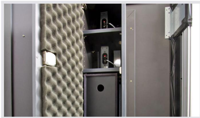
Lautsprechereinbau hinter der Großbildwand-Verkleidung. Medienschränke mit zwei verstellbaren Einlegeböden und zwei VSG-Ganzglastüren.
