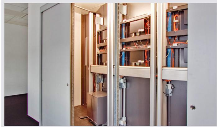
Schiebetüren auf der Rückseite der Großbildwand-Verkleidung als Raum-In-Raum-Funktion. Hinter den Schiebetüren befinden sich die stabilen Display-Racks zur Aufnahme der LC-Displays.
