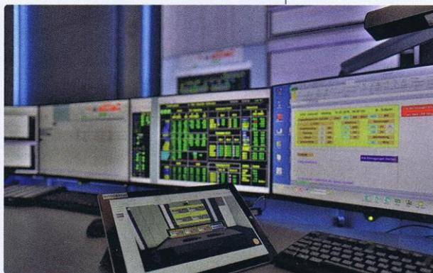
Für die flexible Visualisierung und Bedienung der verschiedenen Leitsysteme ist die so genannte My GUI-Bedienoberfläche (hier auf einem Touchpad) hilfreich.
