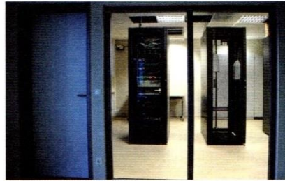
Bild 2 Um Platz im Leitwartenpult zu schaffen und die Wärme- sowie Geräuscentwicklung in dem kleinen Raum zu minimieren, wurden zunächst alle Rechner in einen etwa 10 m entfernten Serverraum ausgelagert.
