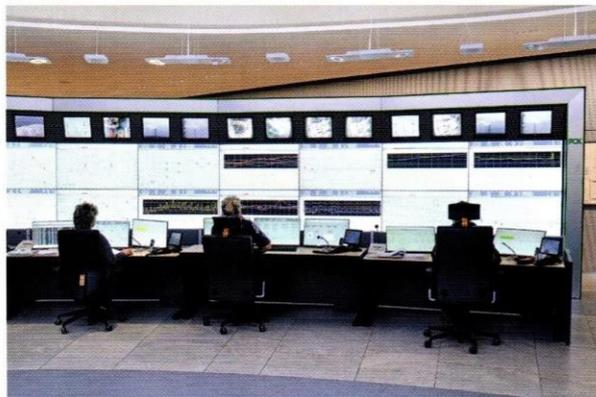
Durch MultiConsoling ließ sich die Zahl der Monitore am Arbeitsplatz reduzieren. Neben sechs Fahrständen mit insgesamt 25 Bedienplätzen und 78 Monitoren wurden Großbildwände mit mehr als 100 Displays installiert.
