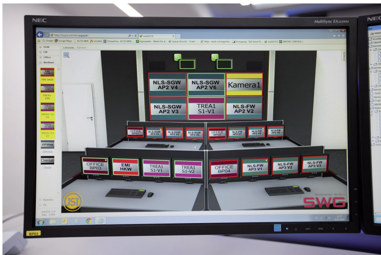
Bild 1 In der MultiConsoling-Komponente myGUI werden alle Konsolen der Arbeitsplätze und die Großbildwand als „Kontrollraumbild“ dargestellt.
