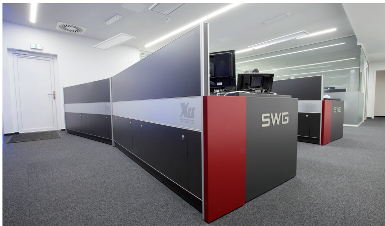
Bild 3 JST baute besonders stabile Stratos-X11-Leitwartentische ein, die für den 24/7-Betrieb ausgelegt sind und für ein ermüdungsfreies Arbeiten sorgen.
