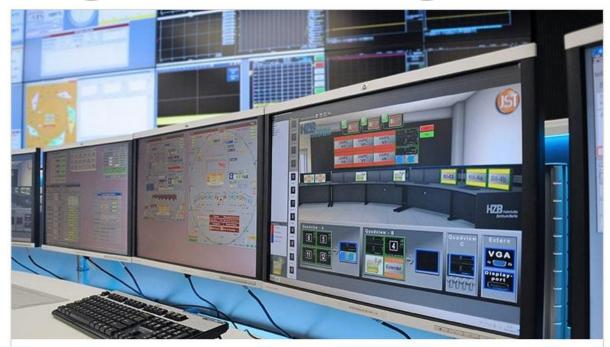
MultiConsoling korreliert Monitore, das heißt, der Anlagenfahrer kann seine Displays frei belegen. Er schaltet sich immer die Anzeige auf einem der eigenen Bildschirme auf, die er gerade braucht. Quelle:
