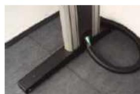
**Dank spezieller Bürstendichtung zwischen Großbildschirm und Verkleidung** wird ein flächenbündiger Abschluss geschaffen. Die zusätzliche Wahl von Akustik-Material senkt den Lärmpegel im Kontrollraum und dient zur Abschottung der Geräusche hinter dem dekorativen DisplayCover.
