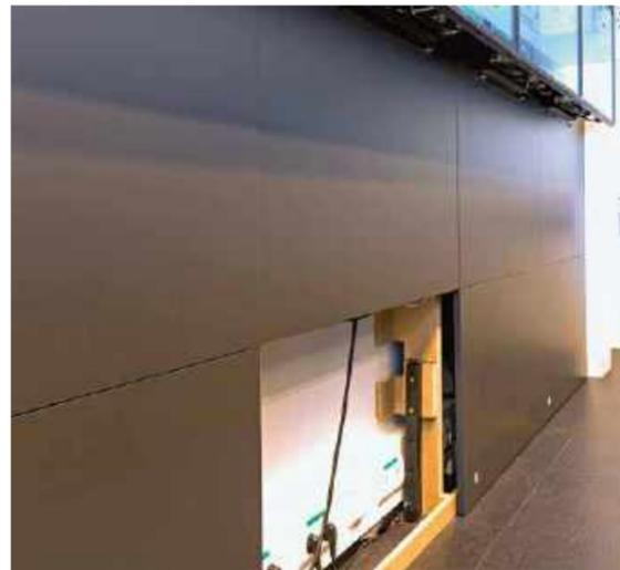
Mit dem Quick-Out-Montagesystem lassen sich einzelne Displays durch leichten Druck auf die Außenkanten ganz einfach nach vorne schieben – selbst im laufenden Betrieb. Außerdem befindet sich hinter jedem Großbilddisplay ein Technikfach. So können die Displays direkt auf den Paneelen des DisplaySuit aufliegen
