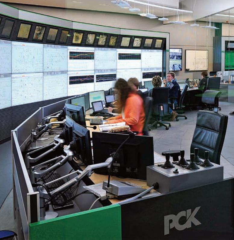
Jungman installierte neben sechs Fahrständen mit insgesamt 25 Bedienplätzen und 78 Monitoren auch Großbildwände mit mehr als 100 Displays, die für die Steuerung der Anlagen eingesetzt werden.
