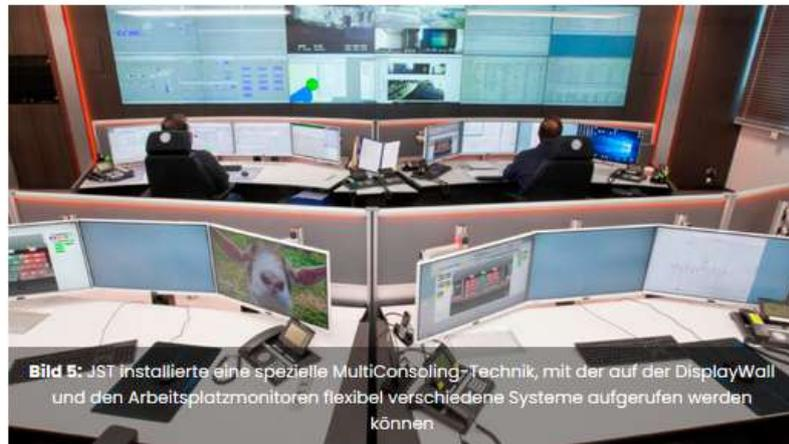
**Bild 5:** JST installierte eine spezielle MultiConsoling-Technik, mit der auf der DisplayWall und den Arbeitsplatzmonitoren flexibel verschiedene Systeme aufgerufen werden können
