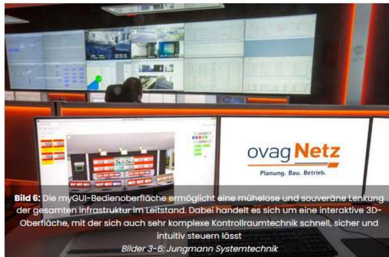
**Bild 6:** Die myGUI-Bedienoberfläche ermöglicht eine mühelose und souveräne Lenkung der gesamten Infrastruktur im Leitstand. Dabei handelt es sich um eine interaktive 3D-Oberfläche, mit der sich auch sehr komplexe Kontrollraumtechnik schnell, sicher und intuitiv steuern lässt
