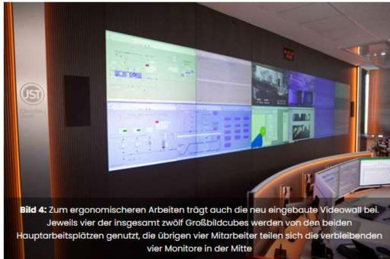
**Bild 4:** Zum ergonomischeren Arbeiten trägt auch die neu eingebaute Videowall bei. Jeweils vier der insgesamt zwölf Großbildcubes werden von den beiden Hauptarbeitsplätzen genutzt, die übrigen vier Mitarbeiter teilen sich die verbleibenden vier Monitore in der Mitte
