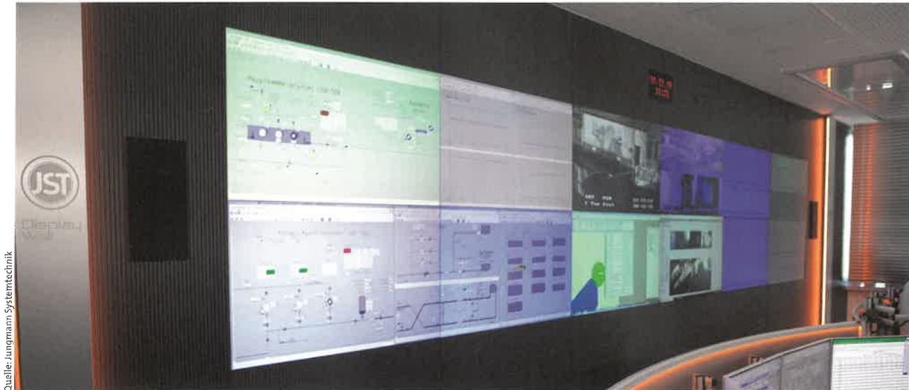
Bild 3. Zum ergonomischeren Arbeiten trägt auch die neu eingebaute Videowall bei. Jeweils vier der insgesamt zwölf Großbildcubes werden von den beiden Hauptarbeitsplätzen genutzt, die übrigen vier Mitarbeiter teilen sich die verbleibenden vier Monitore in der Mitte.
