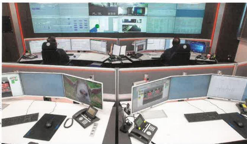
Bild 4. JST installierte eine spezielle Multi-Consoling-Technik, mit der auf der Display Wall und den Arbeitsplatzmonitoren flexibel verschiedene Systeme aufgerufen werden können. Bei der Ovag Netz sind drei der vier Bildschirme an den Hauptarbeitsplätzen in der Regel mit dem Leitsystem belegt, auf dem vierten Bildschirm werden je nach Bedarf Büro-PC, Internet-PC, Tonfrequenzsteuerungs-PC oder die Gebäudeleittechnik aufgeschaltet.
