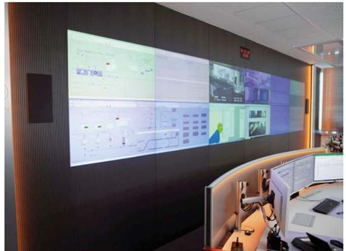
dabei in Echtzeit. Bei der ovag Netz sind drei der vier Bildschirme an den Hauptarbeitsplätzen in der Regel mit dem Leit-system belegt. Auf dem vierten Bildschirm werden je nach Bedarf Büro-PC, Internet-PC, Tonfrequenzsteuerungs-PC oder die Gebäudeleittechnik aufgeschaltet. Für das Umspringen zwischen diesen Systemen reicht ein Tastendruck auf der Shortcut-Bedienleiste des Kontrollpults.
