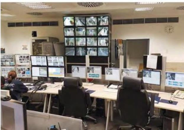
*In der alten Einsatzleitstelle von Protec befand sich eine 70 Zentimeter tiefe Videowand mit 16 Röhrenmonitoren von je etwa 12 Zoll Durchmesser sowie eine Vielzahl von Geräten pro Pult.*
