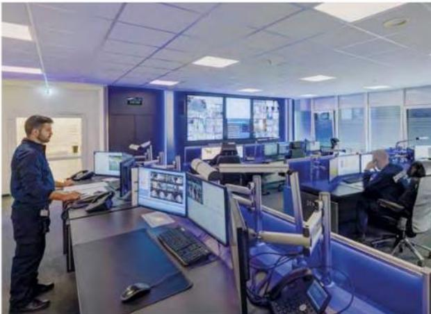
Die vorhandenen Arbeitsplätze sind mit stabilen Stratos-X11-Kontrollraumpulten ausgestattet, die motorisch bis zur Stehhöhe verstellbar sind.
