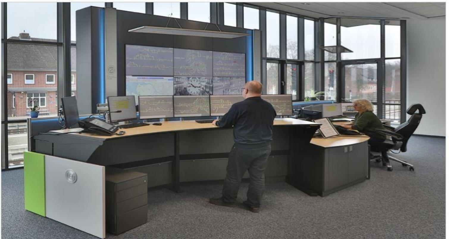
Die Kontrollraumpulte sind motorisch bis zur Stehhöhe verstellbar, so dass variierende Körperhaltungen ermöglicht und einseitige Belastungen vermieden werden. Foto: Jungmann Systemtechnik
