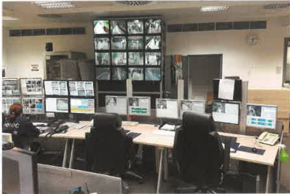
Abb. 1: VORHER: In der alten Einsatzleitstelle von protec befand sich eine 70 cm tiefe Videowand mit 16 Röhrenmonitoren von je etwa 12 Zoll Durchmesser sowie eine Vielzahl von Geräten pro Pult. Der Raum genügte hinsichtlich Platz, technischer Ausstattung und Einrichtung nicht mehr den aktuellen Anforderungen.
