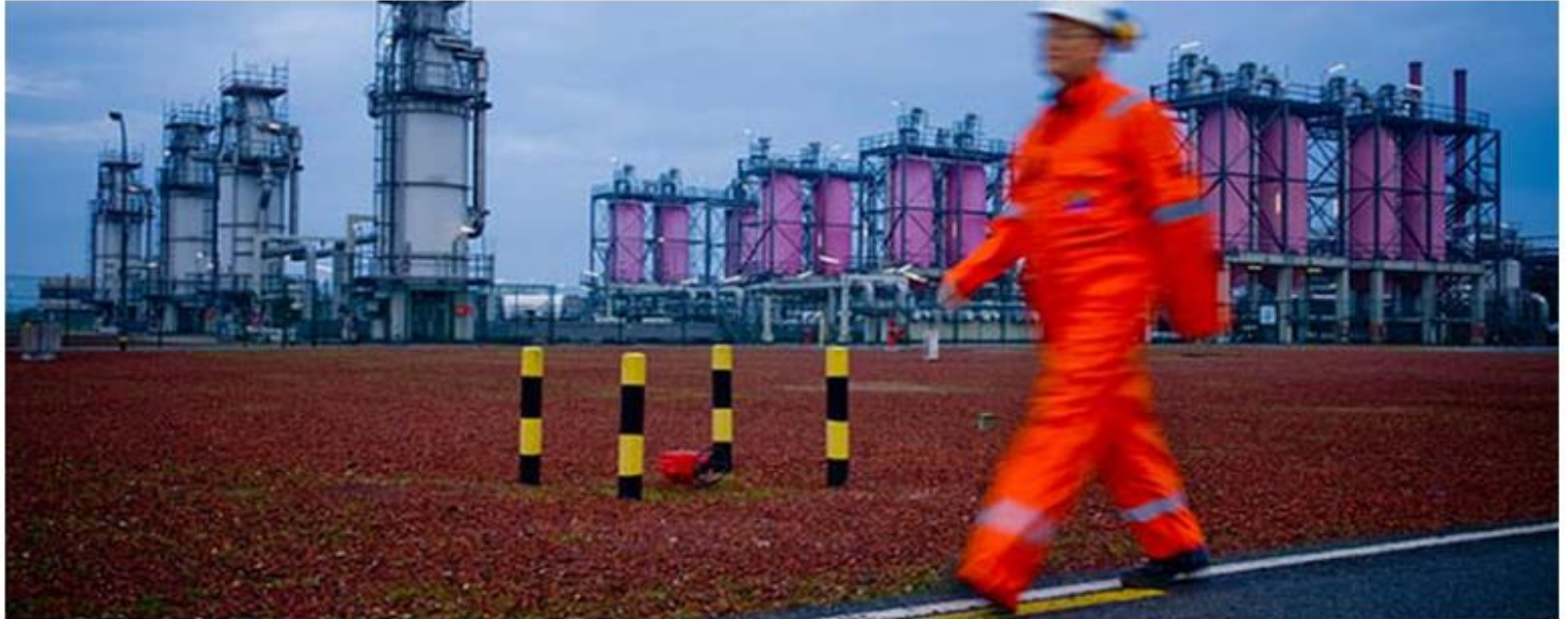
Die EMS prüft die Gasqualität und misst die Gasmenge, bevor das Erdgas an die nachgelagerten Transportunternehmen weitergeleitet wird. Quelle: GASSCO AS
