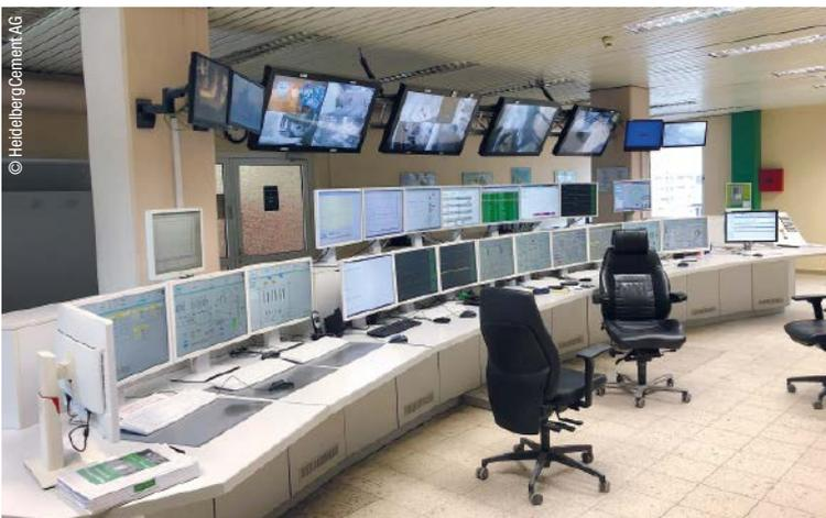
▲ Durch die spezielle Multi-Consoling-Technik können an der Display-Wall sowie auf den Arbeitsplatzmonitoren situationsabhängig verschiedene Systeme, Produktionsdaten oder Kameras aufgerufen und bedient werden.
