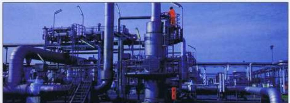
**Bild 5:** In Dornum ist das Unternehmen für die Empfangsanlage der Pipelines Europe I und II zuständig, die seit den 1990er Jahren norwegisches Erdgas nach Deutschland transportieren. In der Empfangsanlage wird der Druck des Gases verringert und es wird aufgeheizt. Quelle: GASSCO AS
