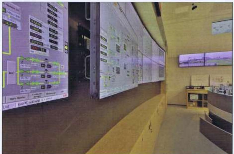
**Bild 3:** Die Displays an der Großbildwand verfügen über ein Quick-Out-System. Auf diese Weise bleibt die dahinter befindliche Technik selbst während des Betriebs für Wartungszwecke zugänglich.
