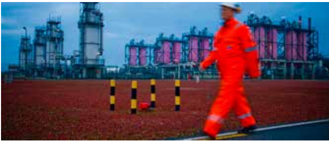
Die EMS prüft die Gasqualität und misst die Gasmenge, bevor das Erdgas an die nachgelagerten Transportunternehmen weitergeleitet wird. Quelle: GASSCO AS
