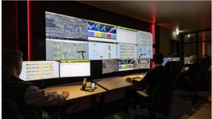
Visuelle und akustische Signale, die mit der Leinwand gekoppelt sind, alarmieren das Team, sobald an irgendeiner Stelle ein Systemfehler oder eine Störung vorliegt. © JST Jungmann Systemtechnik GmbH
