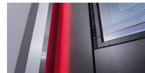
**Dank spezieller Bürstendichtung zwischen Großbildschirm und Verkleidung** wird ein flächenbündiger Abschluss geschaffen. Die zusätzliche Wahl von Akustik-Material senkt den Lärmpegel im Kontrollraum und dient zur Abschottung der Geräusche hinter dem dekorativen DisplayCover.
