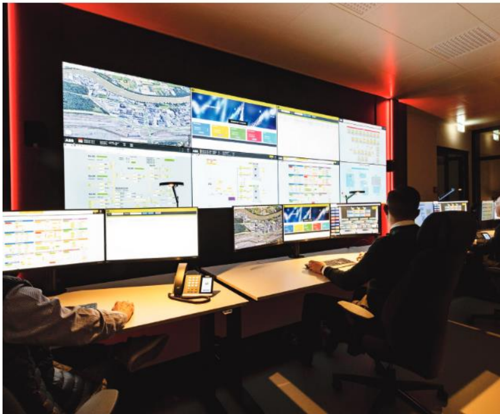
Visuelle und akustische Signale, die mit der Leinwand gekoppelt sind, alarmieren das Team, sobald an irgendeiner Stelle ein Systemfehler oder eine Störung vorliegt.
