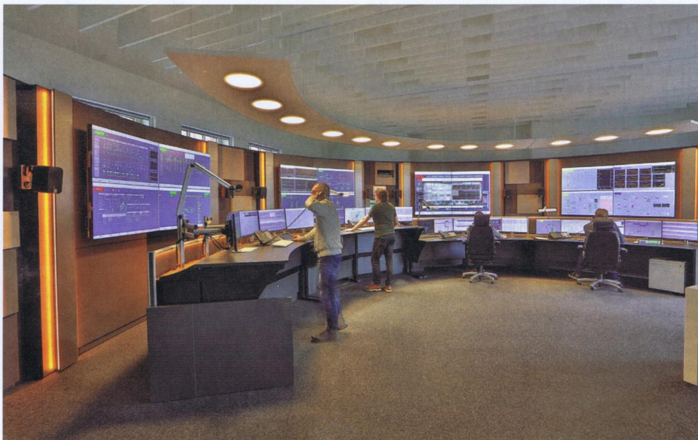
Bild 1: Für eine ergonomische Arbeitshaltung sind die Kontrollraumpulte elektrisch höhenverstellbar.
