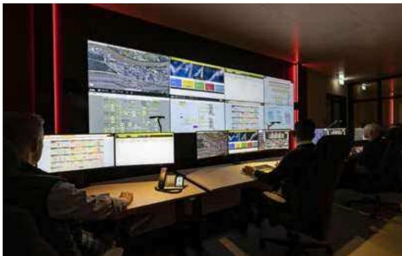
Visuelle und akustische Signale, die mit der Leinwand gekoppelt sind, alarmieren das Team, sobald an irgendeiner Stelle ein Systemfehler oder eine Störung vorliegt. JUNGMANN SYSTEMTECHNIK
