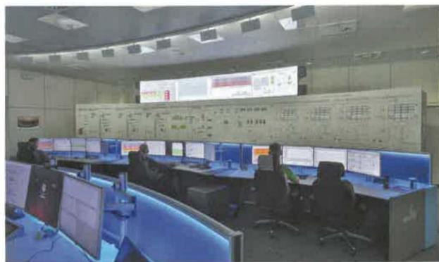
**Bild 2** Die Überwachung der Kraftwerksprozesse wird jetzt durch Großbildwände und eine intuitive Steuerungslösung mit dem KVM-System MultiConsoling unterstützt
