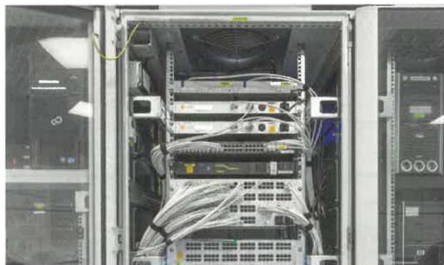
**Bild 3** Das Herzstück im Technikraum bildet das MultiCenter. Dieser zentrale „Umschalter“ sorgt dafür, dass die zahlreichen Signale aller Datenpunkte flexibel und in Realtime auf die Videowalls und Arbeitsplätze geschaltet werden
