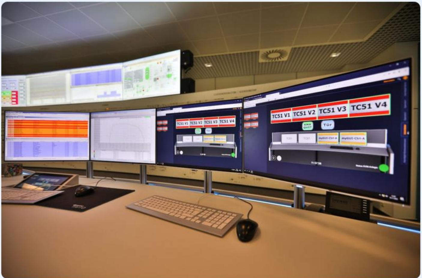
Bild: SachsenEnergie\_Ronny Zeidler | Dank des MultiConsoling-Konzepts lassen sich alle Rechner-, Kamera-, System- und Sensordaten aus den angeschlossenen PCs und Datenpunkten des Heizkraftwerks sowohl an den Operator-Plätzen als auch auf den Videowalls aufrufen.
