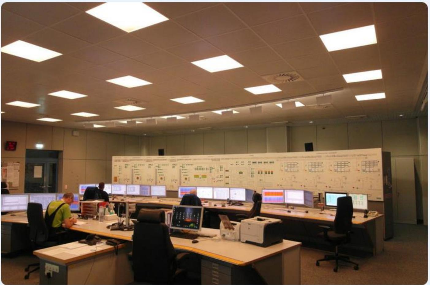
*Bild: SachsenEnergie\_Ronny Zeidler | Die Leitwarte vor der Modernisierung - die alte Leitwarte entsprach nach mehreren systembedingten Umbauten nicht mehr dem Stand der Technik. Mithilfe von JST wurde sie technisch und ergonomisch generalüberholt.*
