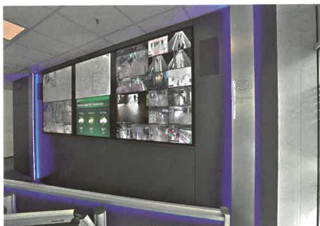
Auch die Zusammenarbeit innerhalb des Teams wurde durch die neue Leitstelle verbessert. Eine Großbildwand mit der Option rahmenübergreifender Big-Picture-Darstellungen ermöglicht den Team-View für alle Operator.
