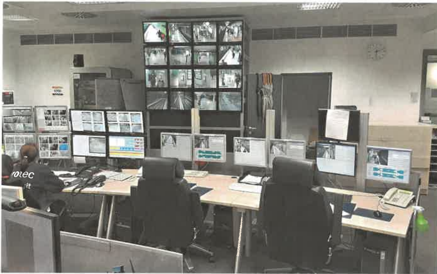
In der alten Einsatzleitstelle von protec befand sich eine 70 cm tiefe Videowand mit 16 Röhrenmonitoren von je etwa 12 Zoll Durchmesser sowie eine Vielzahl von Geräten pro Pult. Der Raum genügte hinsichtlich Platz, technischer Ausstattung und Einrichtung nicht mehr den aktuellen Anforderungen.
