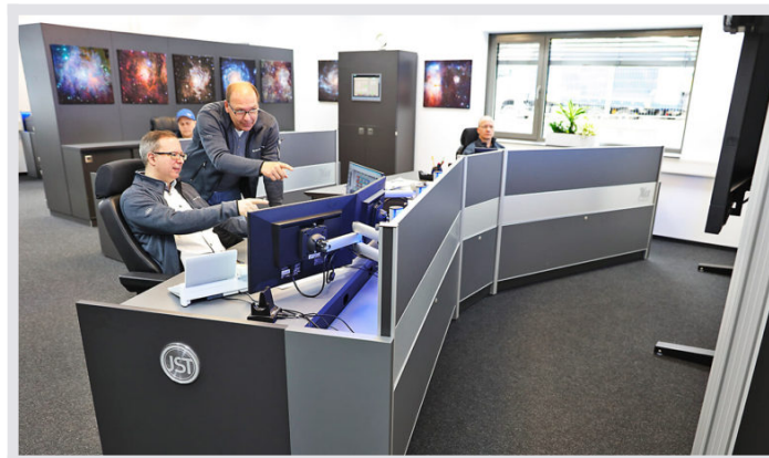
JST Leitwarten-Einrichtung : Nach der Realisierung der Leitwarte wird deutlich: Dem vorab geäußerten Wunsch nach einer einheitlichen Optik konnte kompromisslos entsprochen werden.
