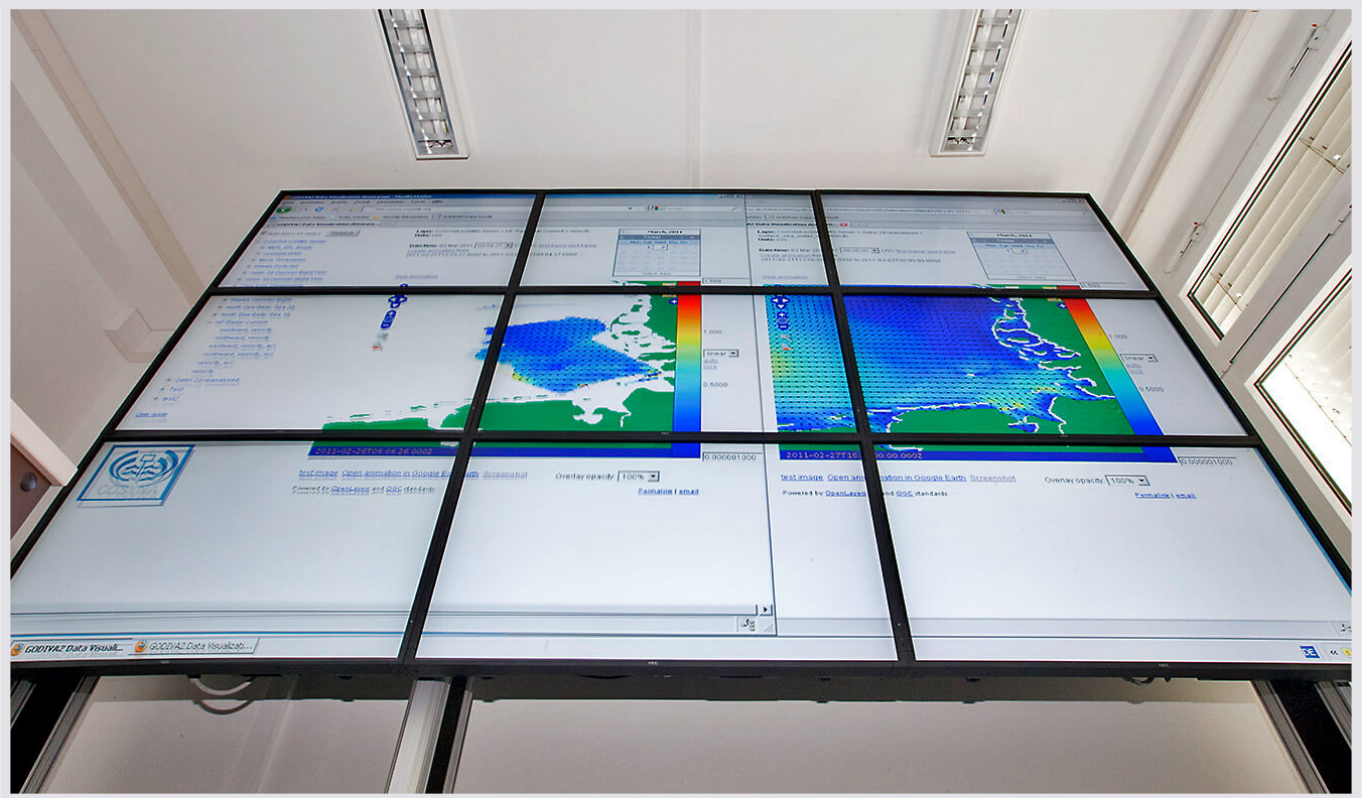
Helmholtz-Zentrum Geesthacht: Großbildwand für die neue Messwarte.
