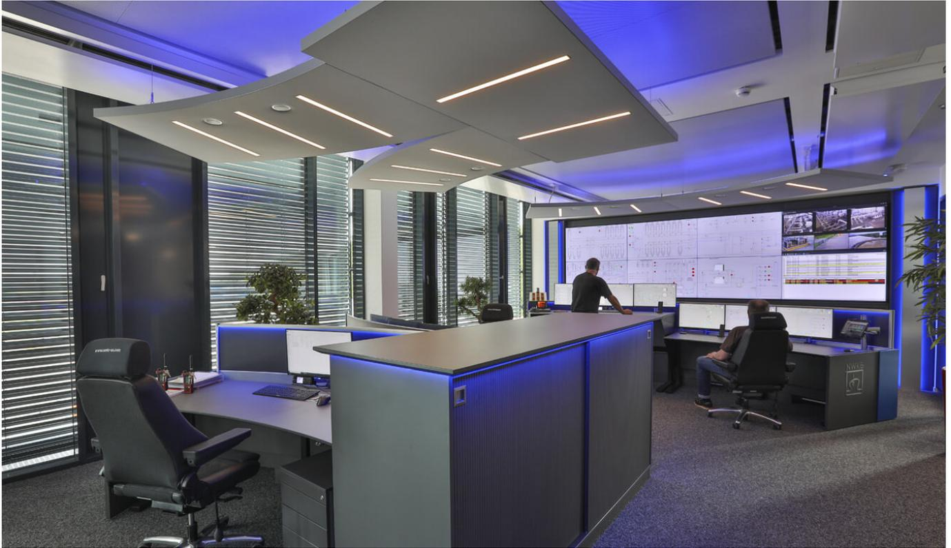
Moderne und ergonomische Arbeitsplatzgestaltung in der hochverfügbaren NWKG Steuerwarte: Für jeden Arbeitsbereich wurde zugunsten optimaler Ausleuchtung und Schallabsorption ein exakt abgestimmtes Akustikdeckensegel installiert.
