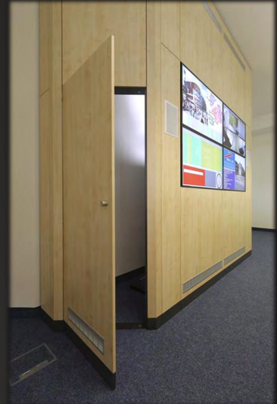
Detailansicht: Zugangstür für den rückwärtigen Wartungsgang.
