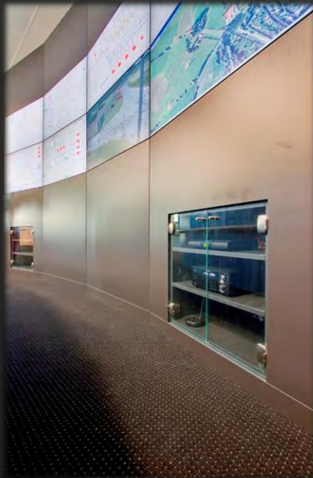
Detailansicht: Medienschränke mit zwei verstellbaren Einlegeböden und zwei VSG-Ganzglastüren.
