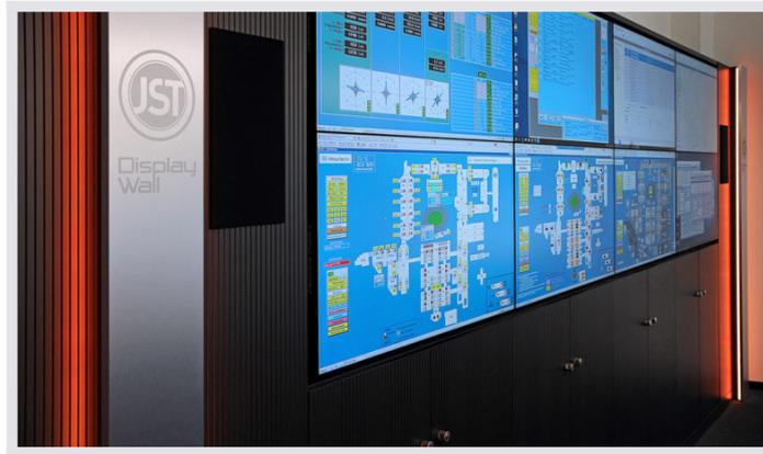
JST Großbildwand: Die JST-DisplayWall mit insgesamt acht 46"-Displays hält das gesamte Kontrollraumteam über die wichtigsten Ereignisse in Realtime informiert. Dafür sorgt eine automatische Quellenaufschaltung, die JST-PixelDetection-Software. Die 24/7 tauglichen Business-Displays sind in einer Großbildwand-Verkleidung installiert; so werden Geräusche und Wärme von den Operatorplätzen ferngehalten.
